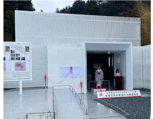
リニューアルした小水力発電所
